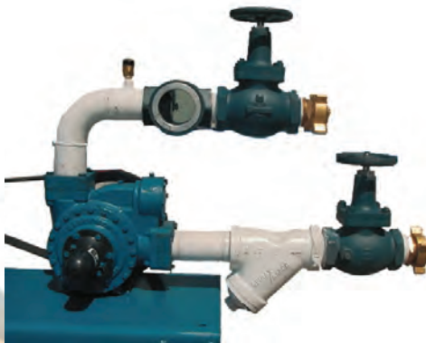
DETALLE TOMAS DE DESCARGA
